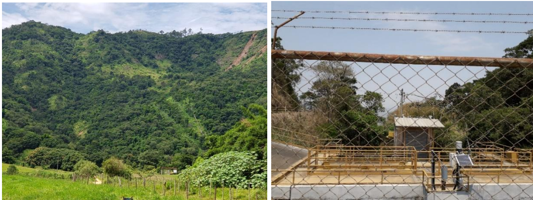
Figura 8 – A direita área da escarpa de falha, com a queda do Rio dos Bagres e entrada da usina e a esquerda área da barragem e turbinas da PCH Ervália.
