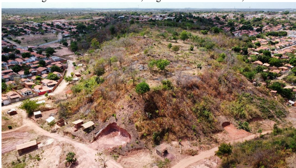
Figura 9 - Morrote de topo convexo de estrutura sedimentar correspondendo a formação Pedra de Fogo, ocupações e taludes instáveis nas vertentes, além da vegetação degradada. Bairro Verde Lar, Região Leste de Teresina, Piauí.
