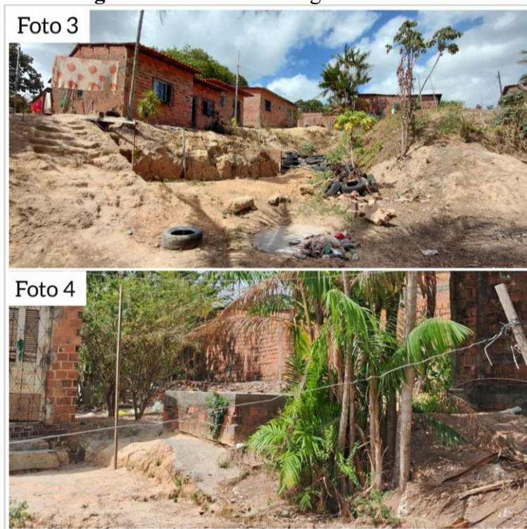
Figura 3 - Canal de drenagem no setor 2.2.
