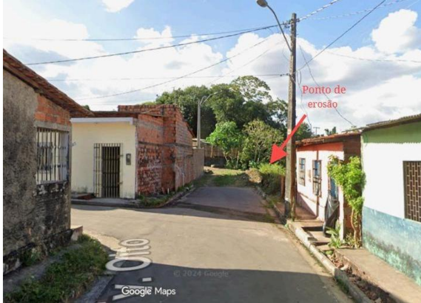
Figura 1 - Casas próximas à erosão no setor 3.1 (Tv. Oito - Recanto Verde).
