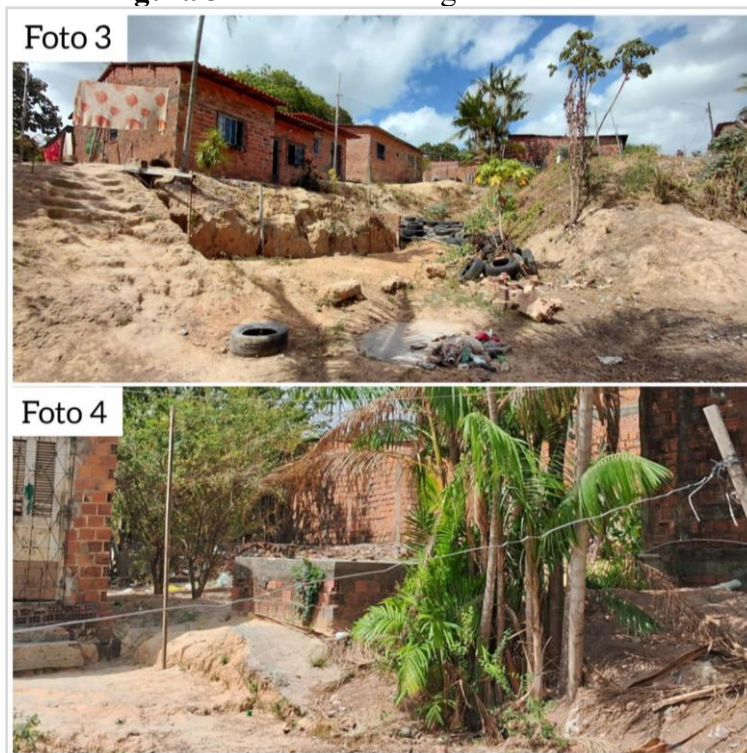
Figura 3 - Canal de drenagem no setor 2.2.
