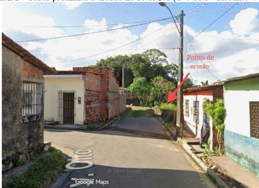
Figura 1 - Casas próximas à erosão no setor 3.1 (Tv. Oito - Recanto Verde).
