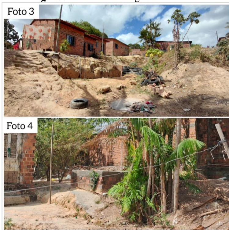
Figura 3 - Canal de drenagem no setor 2.2.
