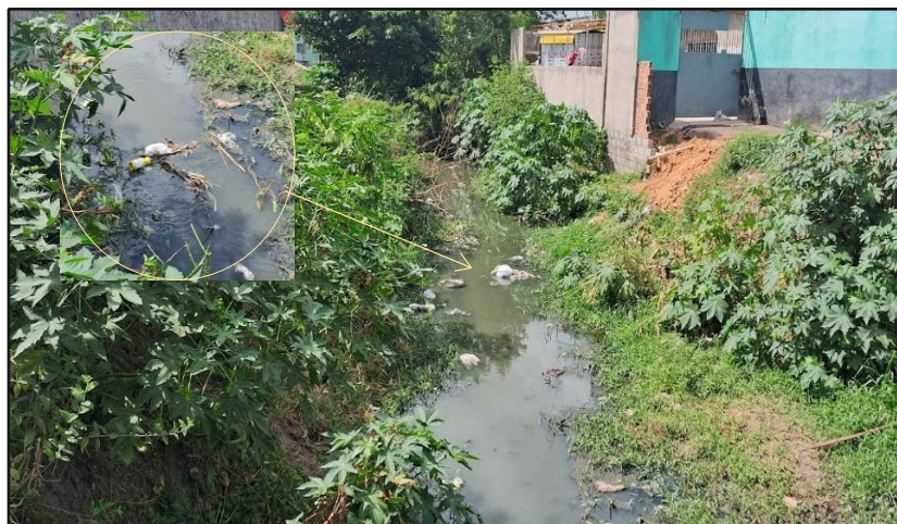
Figura 3 - Setor 1 presen a de res duos s lidos, assoreamento e impermeabiliza  o
