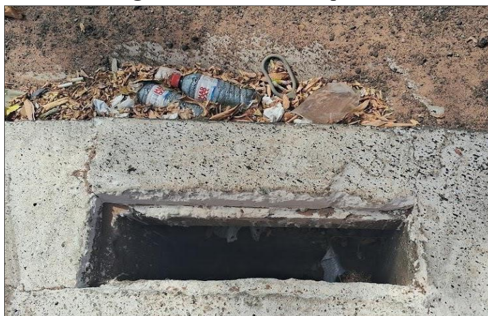
Figura 6 - Canaleta entupida.
