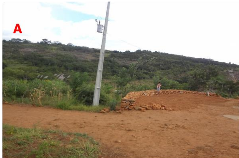
Figura 6 – A) Terraço (cerca de pedra) recém-construído no Quilombo das Águas Claras para acumulação de sedimentos na alta encosta e aumento da área de cultivo; B) Terraços na encosta superior com cultivo de cana-de-açúcar para fabrico de rapadura e cachaça.
