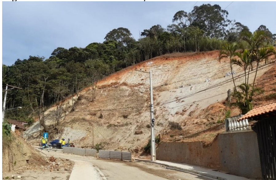
Figura 5 - Início de obra de contenção de encosta na rua Conde D'Eu
