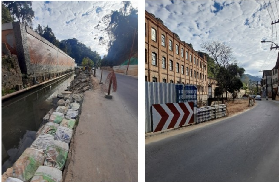
Figura 4 - Obras de reconstrução das margens do rio Quitandinha, na altura da Washington Luiz
